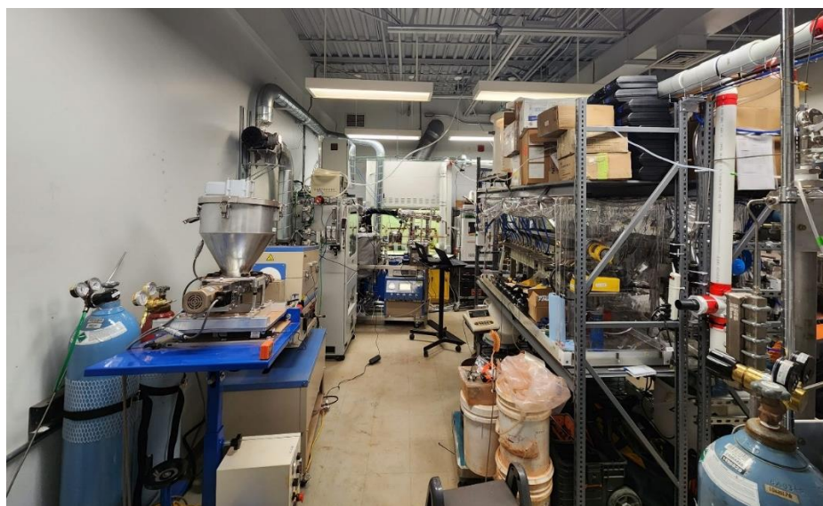
Figure 1: Installation de l'usine pilote dans les installations de Boucherville
