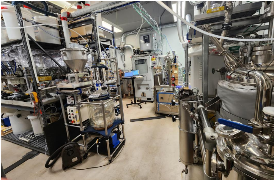
Figure 2: Installation d'une usine pilote dans les installations de Boucherville
