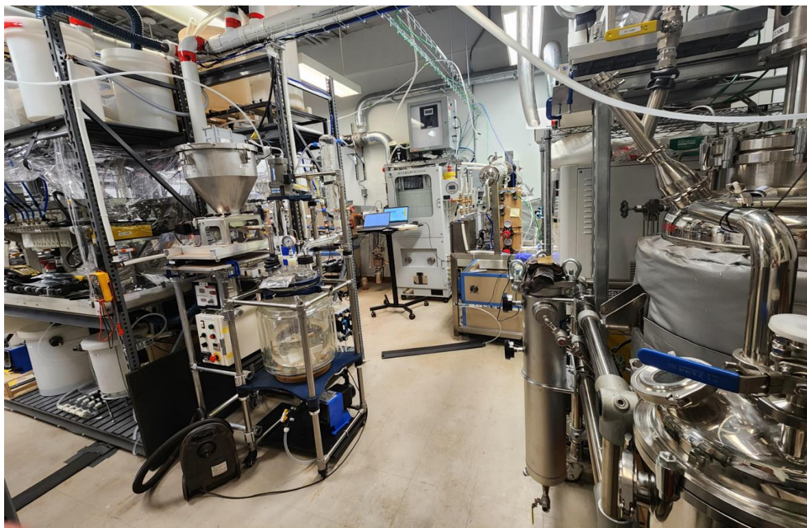
Figure 3: Installation d'une usine pilote à l'usine de Boucherville
