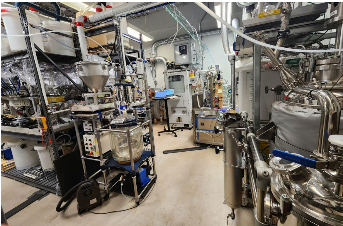
Figure 3: Installation de l'usine pilote à Boucherville – partie 2
